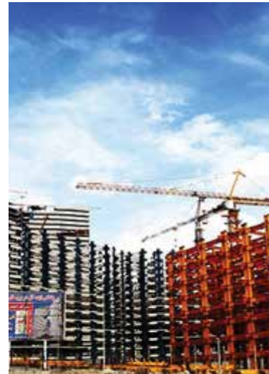
پروژه مجتمع مسکونی بتاجا - تهران
