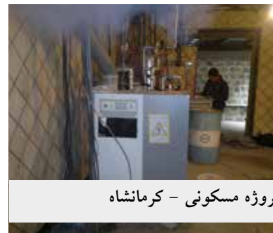
پروژه مسکونی - کرمانشاه
