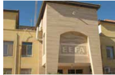
ساختمان اداری کارخانه کاشی ایفاسرام- یزد
