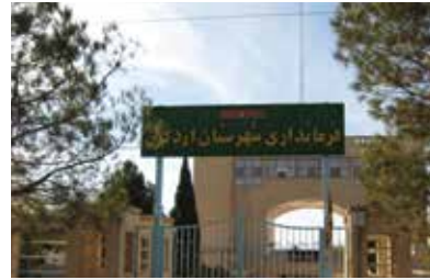
پروژه فرمانداری اردکان - یزد
