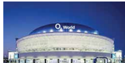
ساختمان مرکزی مجهز به سیستم های گرمایشی WOLF - آلمان
